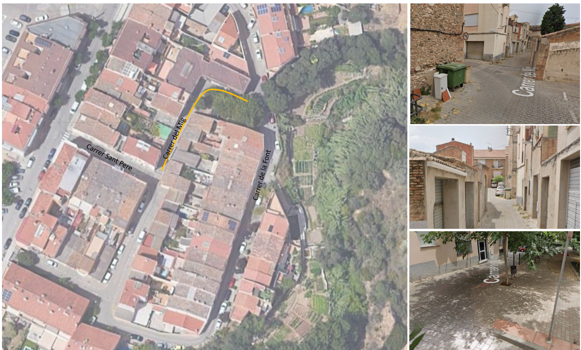
Carrer del Mig entre el carrer de Sant Pere i Carrer de la Font
